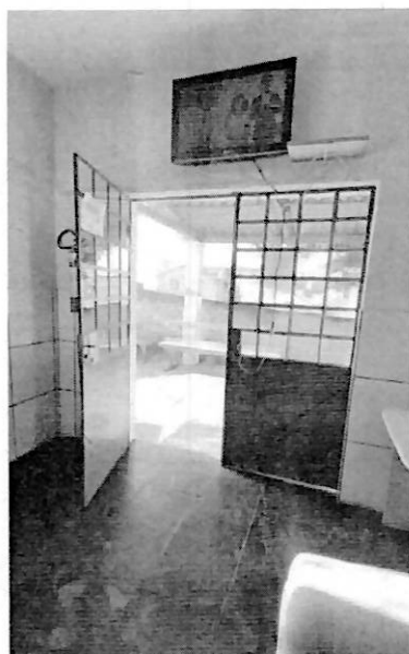
Porta da sala de espera
