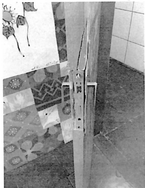
Porta e divisória existentes na sala 02
