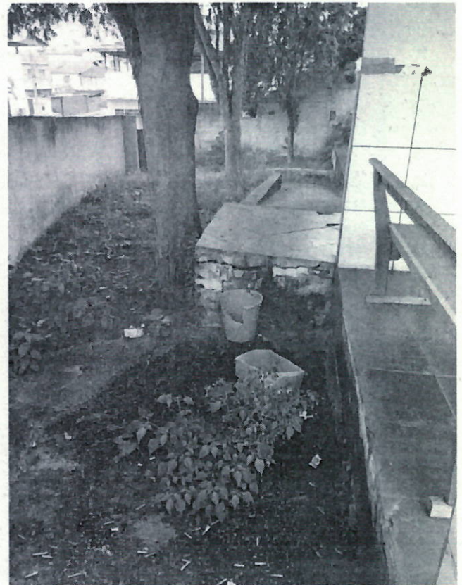
Patamar da rampa
